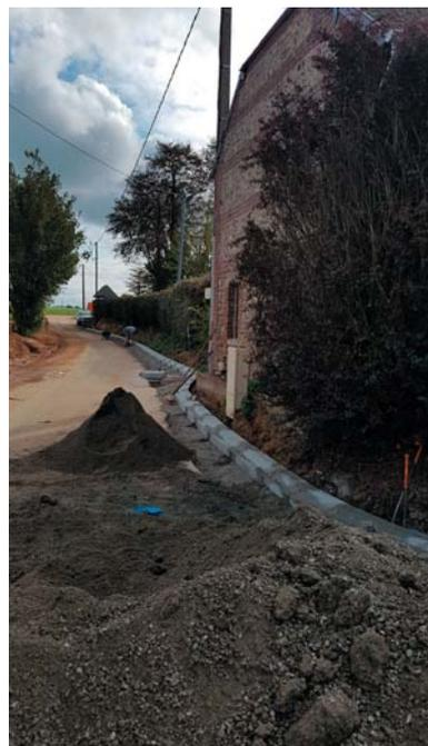
**Route d'Etretat**, une nouvelle tranche de travaux d'effacement des réseaux électriques et téléphoniques a débuté l'hiver dernier et est en cours de finition. De nouveaux lampadaires à éclairage LED ont été installés. Prochainement, les anciennes lignes électriques et les poteaux vont être enlevés et ensuite les trottoirs seront remis en état.
