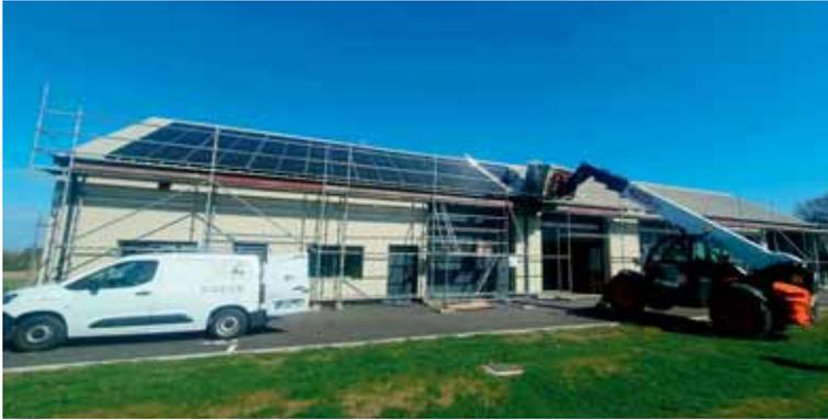
105 panneaux photovoltaïques ont été installés sur le versant sud de la toiture des ateliers : 56 pour le SDE 76 et 49 pour la commune avec une puissance de 22 kw crête. Nous attendons leur raccordement imminent au réseau ENEDIS.
